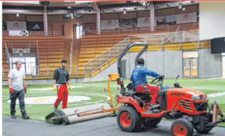
Bahn für Bahn entsteht das Spielfeld für den BWK-Arena-Cup in der Arena Ilshofen. Mitarbeiter der Firma Polyan verlegen den Kunstrasen und bauen ihn wieder ab. Das Feld wird seit neun Jahren beim Turnier verwendet. Foto: Luca Schmidt
